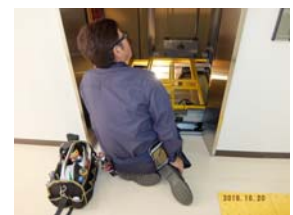
エレベーター点検立会い
