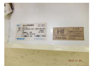
附属学校支援課事務所蛍光灯2灯式安定器不良及び型番
