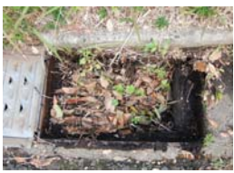
本部庁舎東キュービクル道路前の排水溝の汚泥・木の根等の除去清掃
