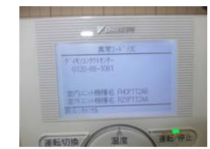
F11講義室のダイキンパッケージエアコン(空冷ヒートポンプ式)点検
