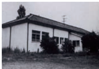
兵舎を移設転用した女子ロッカールーム
